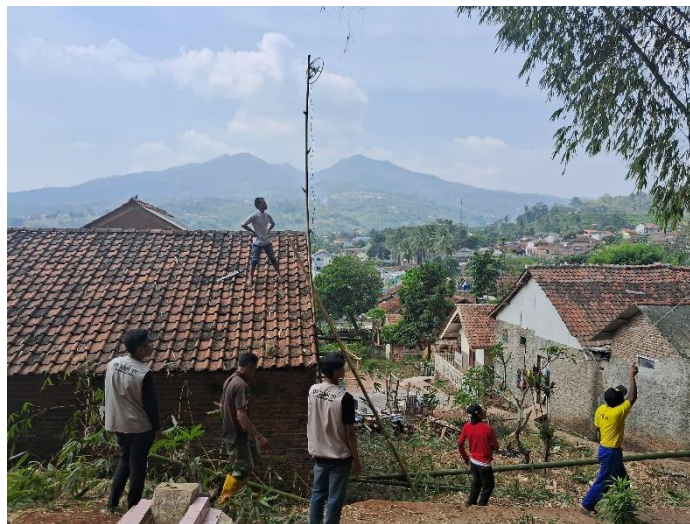
Gambar 2. Pemasangan balok kayu untuk alas tong sampah
