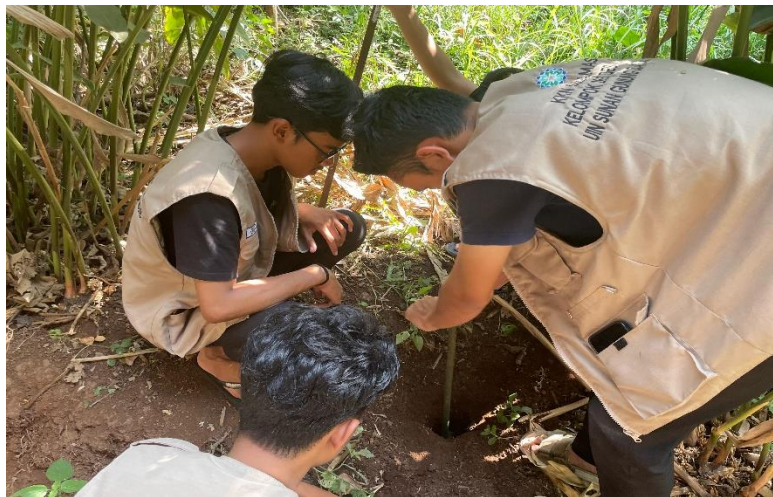
Gambar 4. Pembuatan Contoh Lubang Biopori
