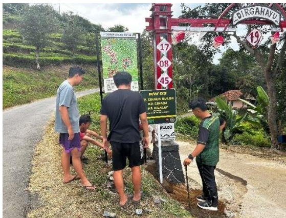
Gambar 10. Pemasangan Denah lokasi RW 03 desa Cupunagara
