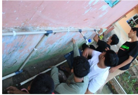
Gambar 3. Pemasangan saluran air
