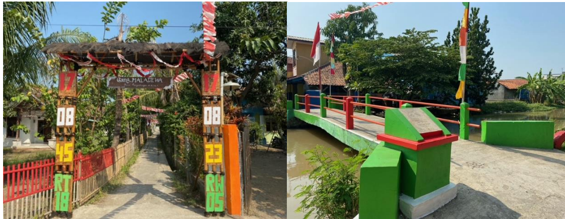
Gambar 2. Pembuatan gapura dan pengecatan ulang jembatan
