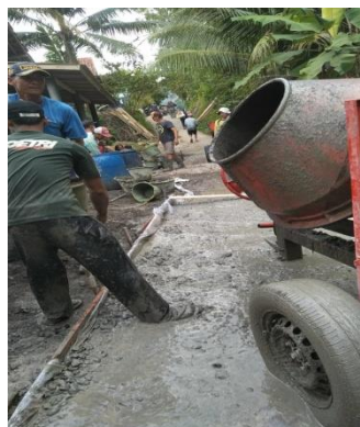
Gambar 8. Kerja bakti mengecor jalan desa
