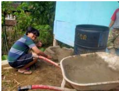
Gambar 18. Pembuatan drum pembakaran sampah
