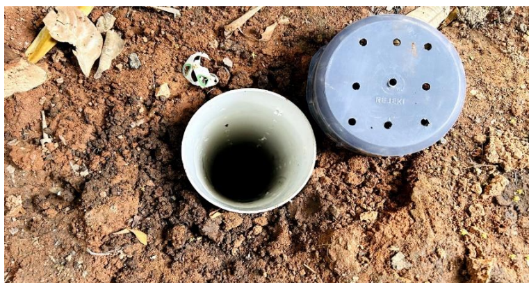
Gambar 7. Lubang Resapan Biopori (LRB) program KKN 172 Desa Cihanyir
