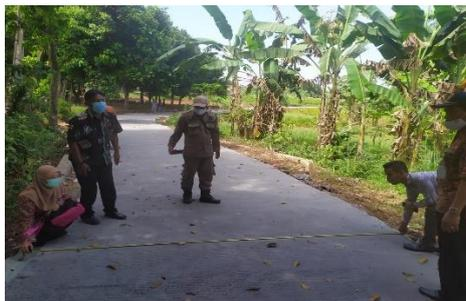
**Gambar 2.** Pengukuran terhadap jalan yang sudah dibeton.
