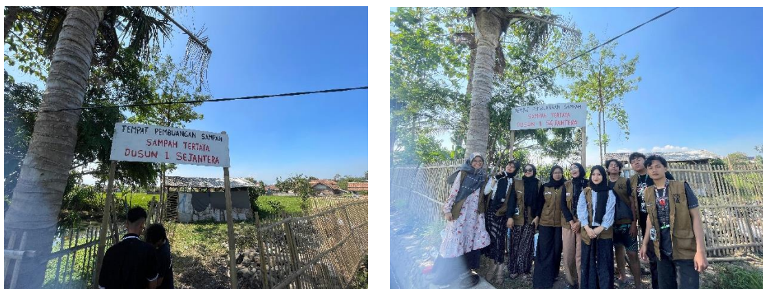
Gambar 2. Kondisi TPS Dusun 1 Desa Panyadap Setelah di Perbaiki
