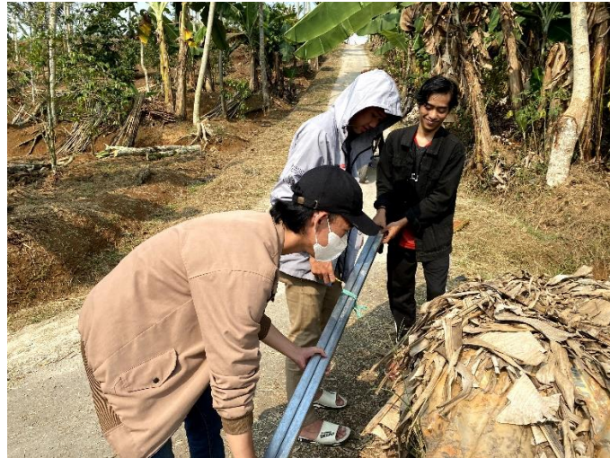
Gambar 2. Pemasangan Tiang PJU
