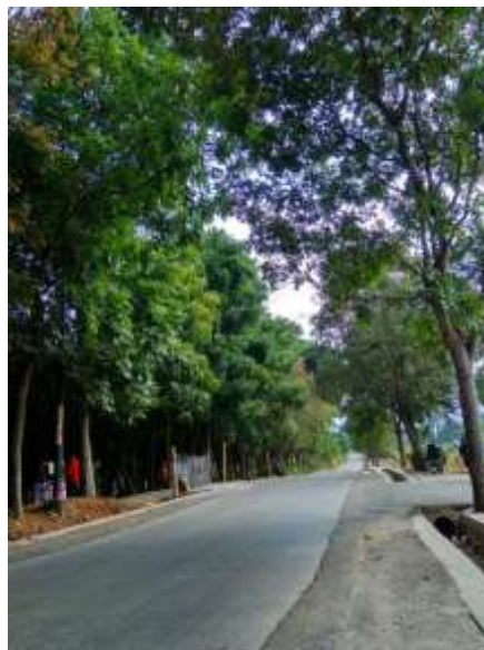
Gambar 5. Kondisi Jalan Agrowisata Tangga 100
