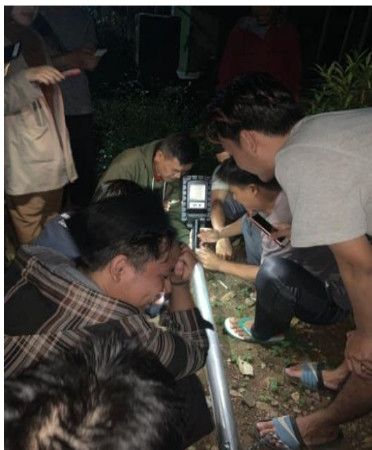
Gambar 3. Proses pemasangan lampu solar Sel pada tiang penyangga
